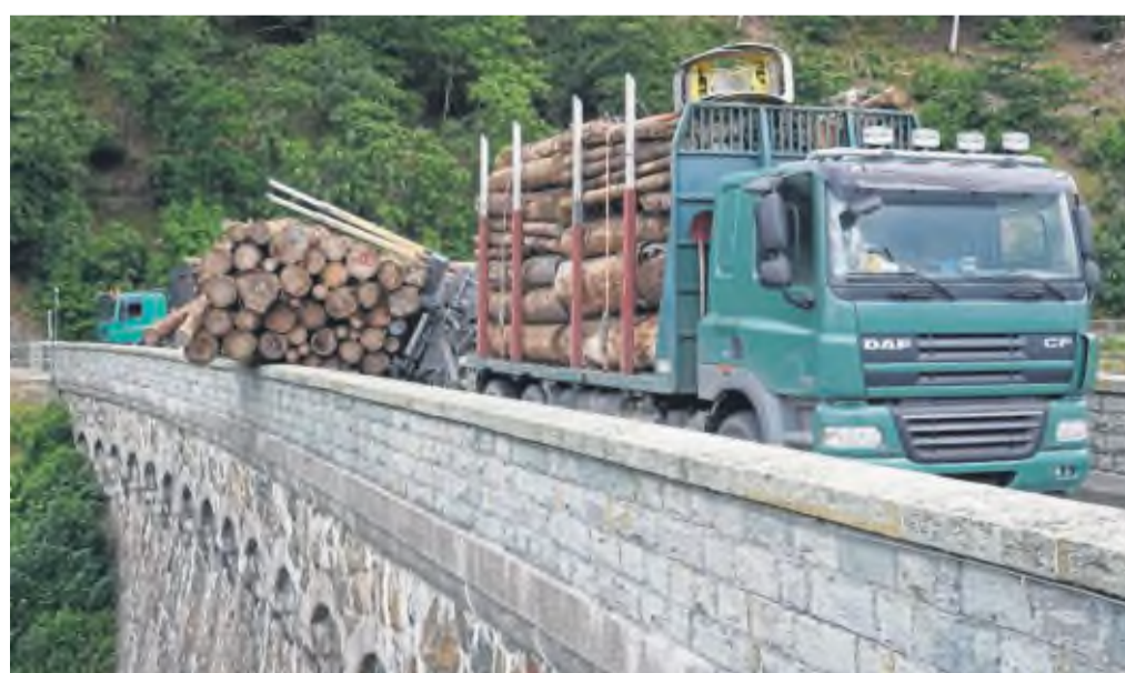
Unfall auf der Diemelsee-Sperrmauer: An dem Anhänger dieses Holzlasters brach laut Polizei ein Federbein. Dadurch geriet der Hänger schlagartig in Schiefelage. FOTO: HANS PETER OSTERHOLD
